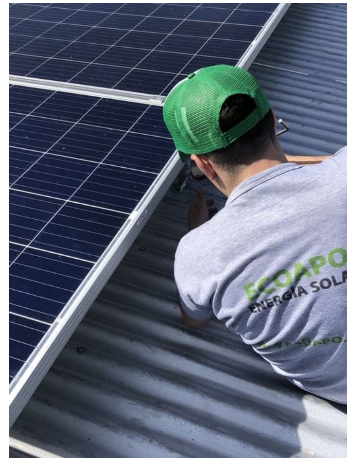
Equipo de EcoApo durante una instalación solar.
